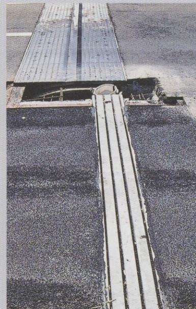
Remplacement d'un joint à lamelles mobiles par un joint de dilatation MAURER à traverses pivotantes
